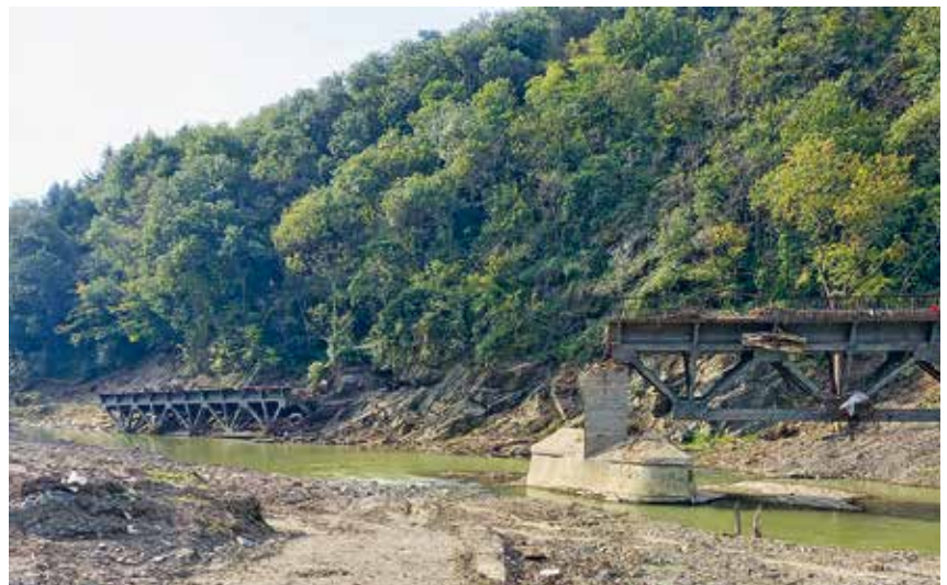
Sogar massive Stahlbrücken wurden bei der Katastrophe zerstört.
