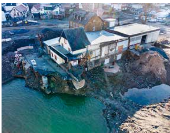
Von der Flut weggerissen: Ruine eines Gebäudes am Ufer der Ahr
